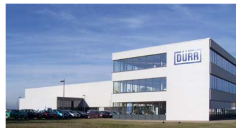
Abb.: Gebäude Dürr Somac GmbH
